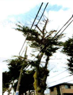
枯れ下がり、電線接触
