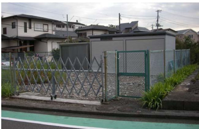
すみれが丘町内会の防災備蓄倉庫
